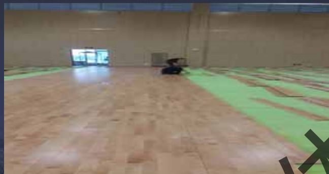
11, 面板铺设安装
