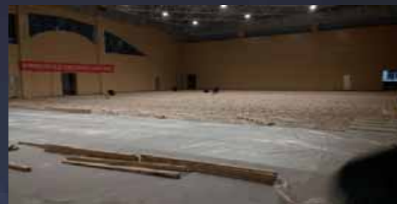
3, 龙骨第一次定位安装
